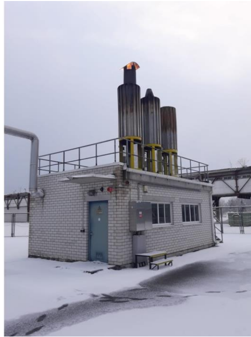
Foto 2. Gaasikell (vasakul) ja jääkgaasipõletid (paremal)
