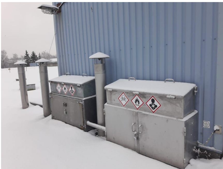
Foto 7. Metanooli vastuvõtukapp/tarnesõlm
